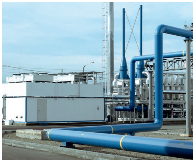
Рис. 1. ККР 3000 производительностью 3000 м 3 /ч. Новороссийский мазутный терминал
