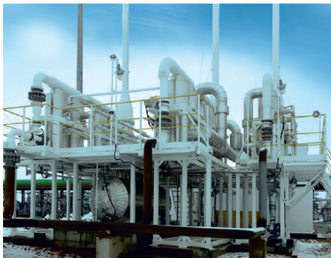
Рис. 3. ККР 1200, производительность 1200 м 3 /ч. Фанипольская нефтебаза, РУП «Белорусьнефть-Минскоблнефтепродукт»
