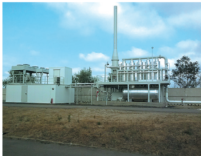
Рис. 4. ККР 1000 производительностью 1000 м 3 /ч. Терминал нефтепродуктов ЗАО «Азовпродукт»
