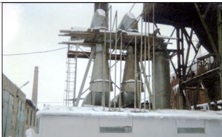
Установка с двумя параллельно работающими скрубберами Вентури для комплексной очистки газов, отходящих из мартеновской печи. Суммарная производительность по газу 75000 м 3 /час.
